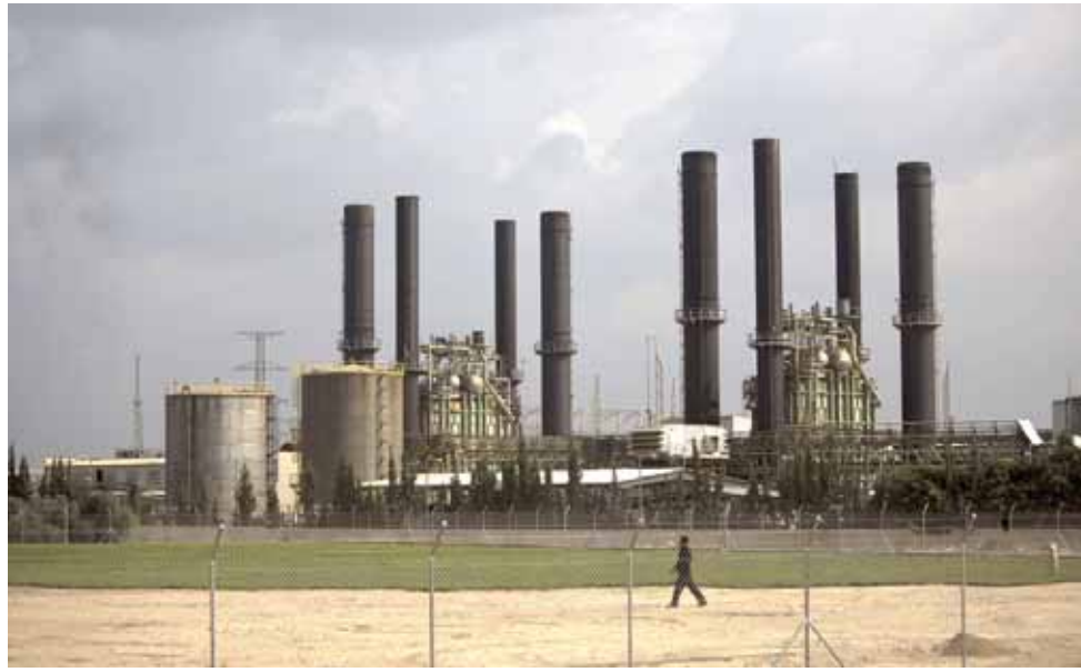
محطة كهرباء غزة
